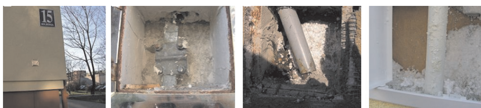
Rzekomy dostęp do zacisków przewodu ukrytego pod styropianem
