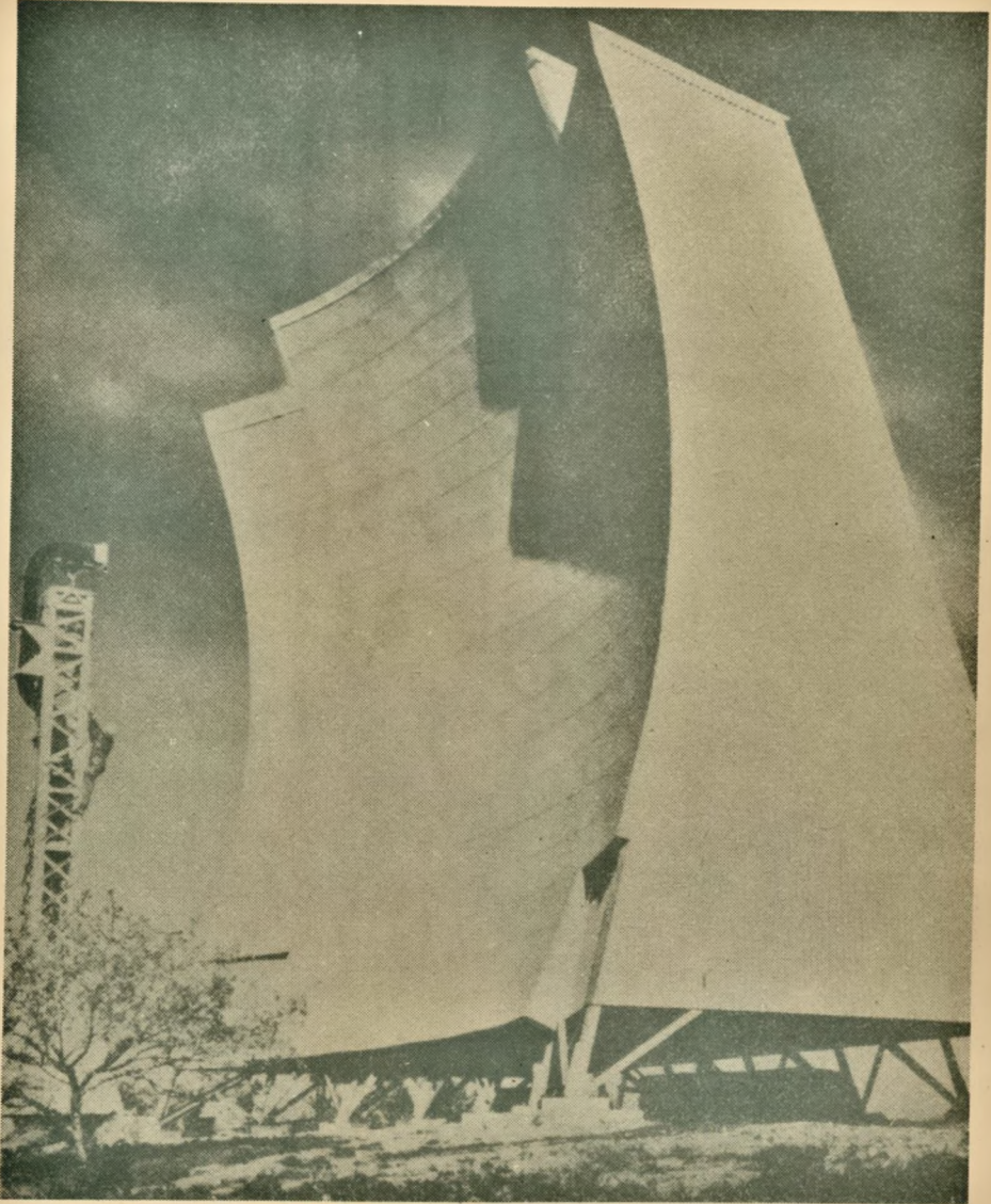
Rys. 13. Anteny stacji linii radiowej, pracującej na fali rozproszonej
