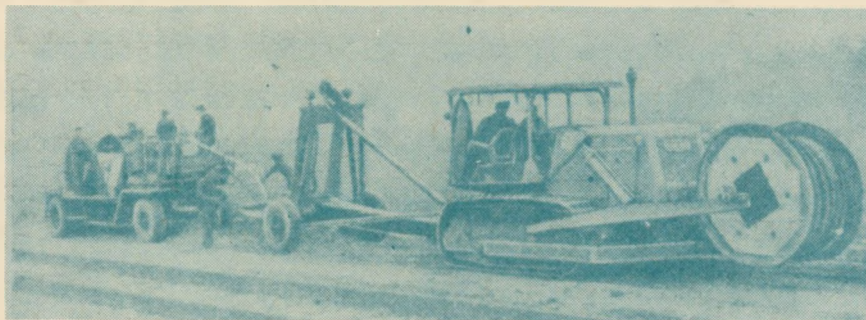
Rys. 4. Ciężki zestaw do układania kabli w czasie pracy
