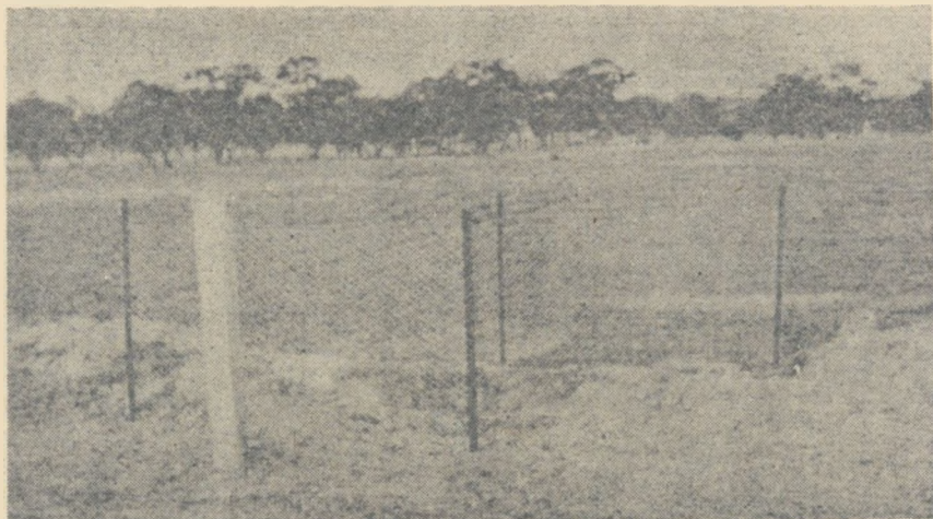
Rys. 9. Prowizoryczne ogrodzenie studni złączowej. Z boku widać normalny słupek oznaczeniowy
