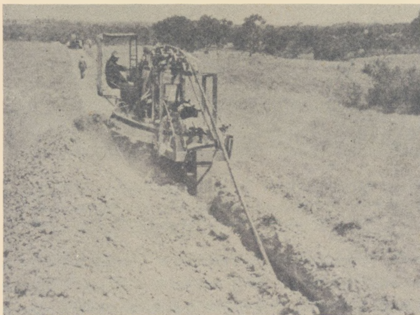
Rys. 3. Widok pracującej koparki typu BG 774 (widać kabel rozwinięty przed koparką i układany przez nią do rowu)
