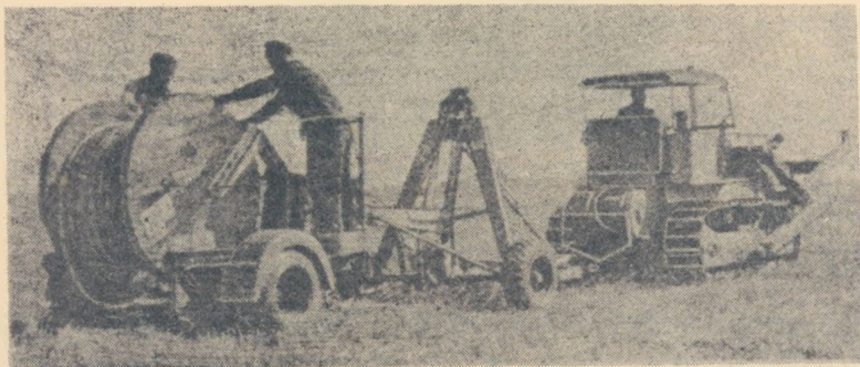
Rys. 3. Układacz kabli typu 60/16 na stanowisku roboczym
