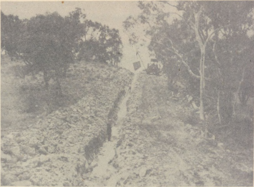
Rys. 15. Sypanie piasku do rowu kablowego za pomocą wagonu z otwieranymi klapami. Całość zamontowano na ciągniku typu HD 11 i wyposażono w dźwig z bocznym ramieniem nośnym
