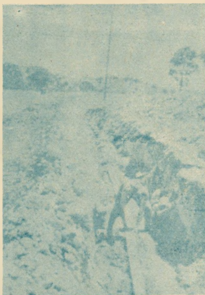
Rys. 17. Przykrywanie kabla w skalnym wykopie deskami zabezpieczającymi
