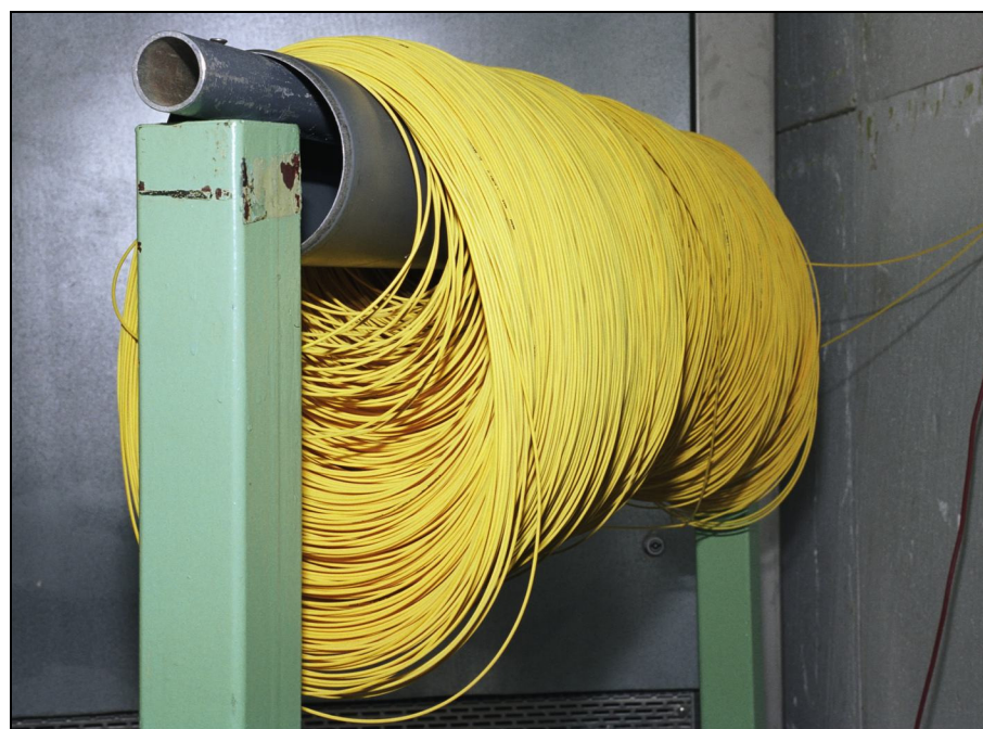
Rys. 125. Zawieszenie kabla na rurze podporowej. Próbką NOTKS-1 – badanie Nr 2.
