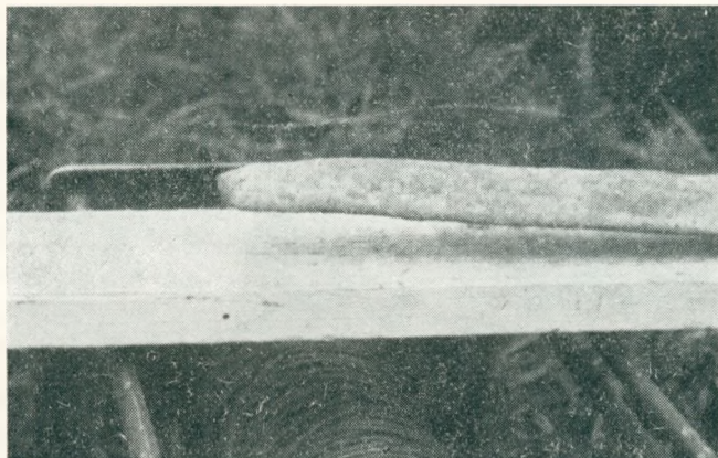
Rys. 9. Skorodowana część końcowa anody cynkowej wykopanej z ziemi po około dwuletnim okresie pracy
